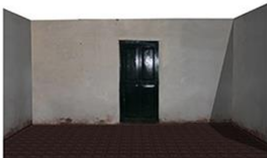
1. Retirar cubierta existente y colocar sobrecubierta plástica para protección de la obra.
