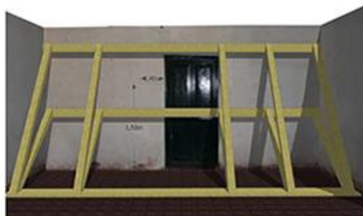
2. Colocación de entibado para garantizar la estabilidad de los muros, se apuntalara cada uno de los pies derechos de la construcción (revisar plano estructural para ubicación de pies derechos)
