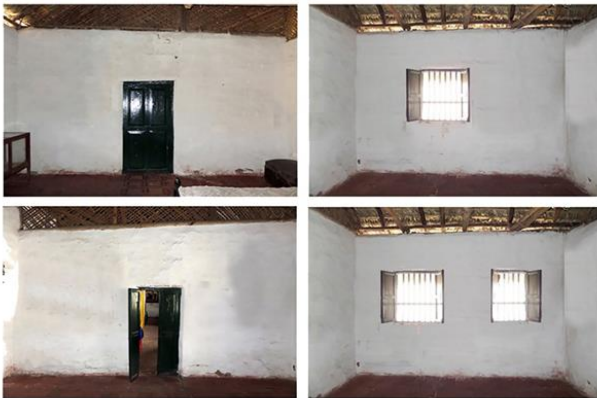
Ilustración 5. Reconocimiento y análisis del proyecto a trabajar. Fotografías de los elementos a intervenir, mediante la reparación de su estructura.
