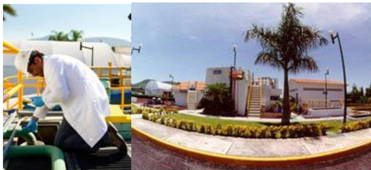
Figura 3. Planta de Tratamiento de Aguas Residuales del IMTA.
